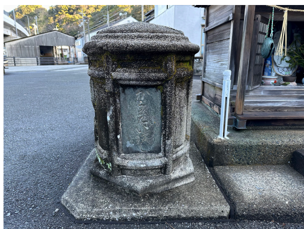
奈半利町未指定文化財 旧かうえい橋親柱
