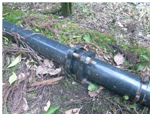
【ポリエチレン管(2種)-3FN継手】
