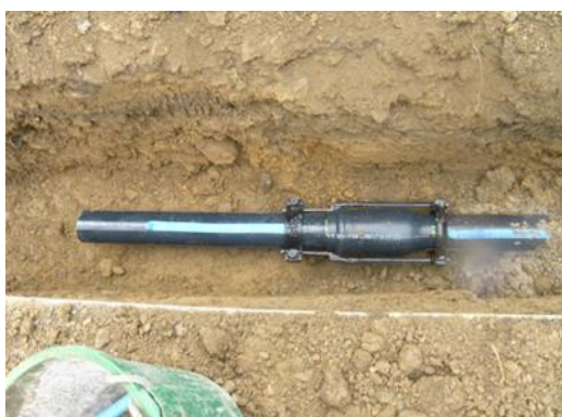
【耐衝撃性硬質塩化ビニル管-ゴム輪形ロング継手】
