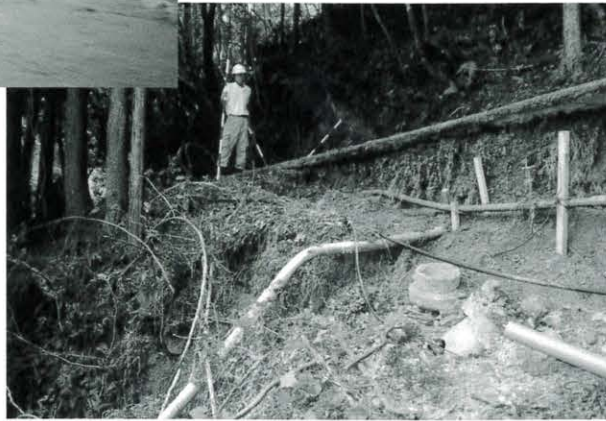
▲ 魚梁瀬道 東川の岩城實さん宅かみ路面崩壊のため水道本管が裂ける
