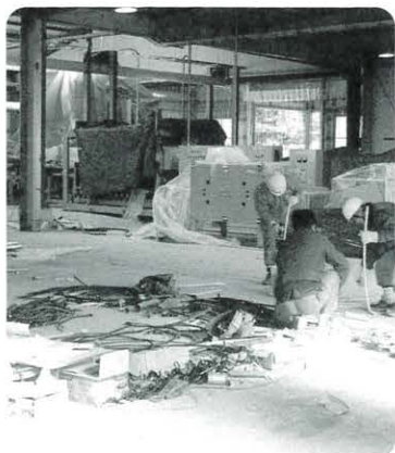
エコアス馬路村 (建設中の写真です)
