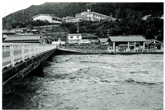
台風23号による安田川のはんらん(10/20) (西野商店前からの馬路保育所付近を撮影)
