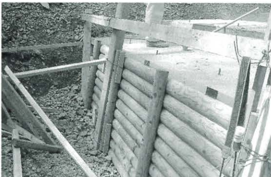
▶ 工場現場で使われている型枠
