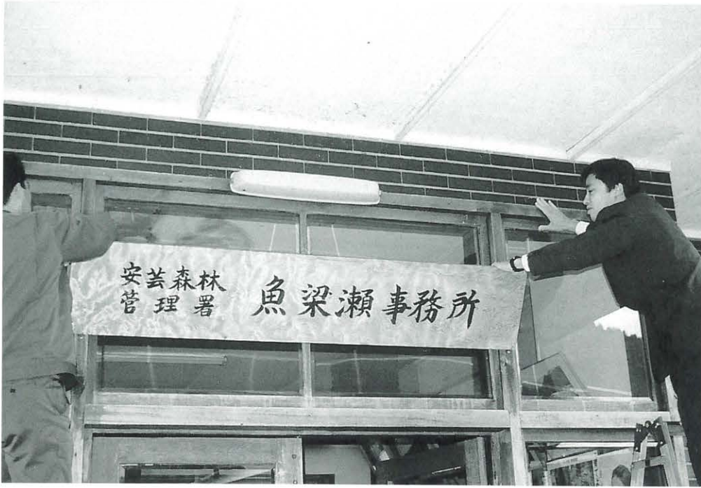
新看板を取り付ける高原繁魚梁瀬事務所長
