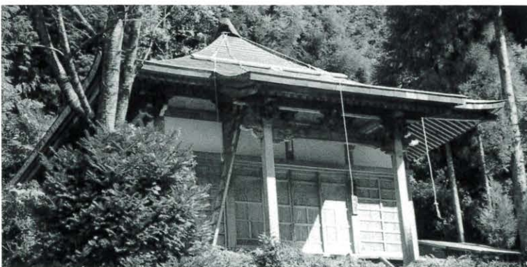
城福寺 魚梁瀬地区の北方（山裾）存す
