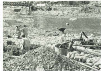
(工事中の貯水槽附近)
