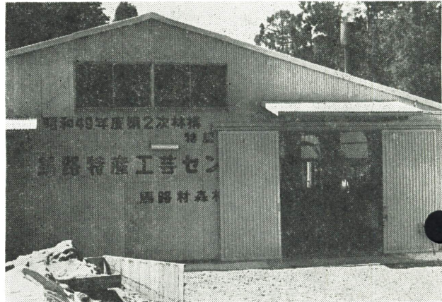
完成した工芸センター
