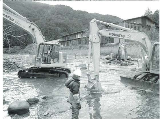
1mを超える巨石を活用し(写真上)、掘り下げられた川底に配置している様子(写真下)
