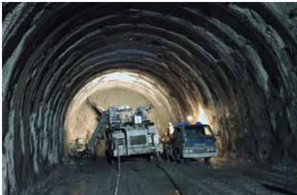
▲▼トンネル内掘削作業の様子
