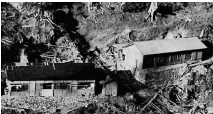
対岸のそま小屋。水場をはさんで白く光る屋根が風呂場。20数人が共用で使う。そのため木製の浴槽も3〜4人が一緒に入れる大きさがあがる。まきでわかした湯が外から循環してくる。板張りの洗い場ではついでに洗濯もし、軒下に干す。その裏に斜めに黒っぽく見えるのが発電用の導水鉄管で、上の木製水槽から下の発電小屋（黒い屋根）へ水を落とす。午後9時ごろには発電を停止した
