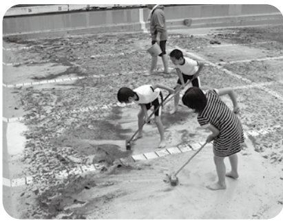
▲魚梁瀬小学校のプール 汚れが簡単に落ちていきます!!
