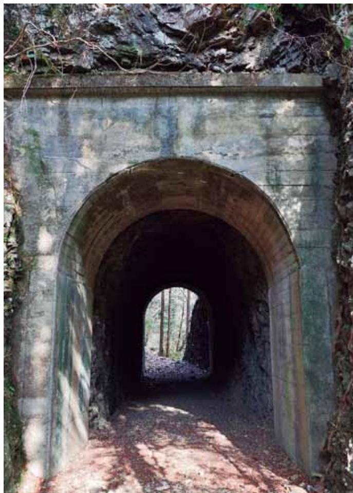
上/雁巻の窓に接する林鉄隧道。坑口は崩落防止のためにコンクリートで補強してあるが中は岩盤をくりぬいただけの素掘り仕上げである
