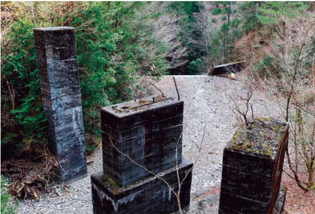
上/3基のコンクリート製橋脚が谷から立ち上がっている。手前の2基の頂部からは木製の構造材で軌道面をささえていたのだろうか。この谷で軌道はおおきく曲がっている
