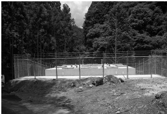
▲上流側からの栃谷ろ過池全景
