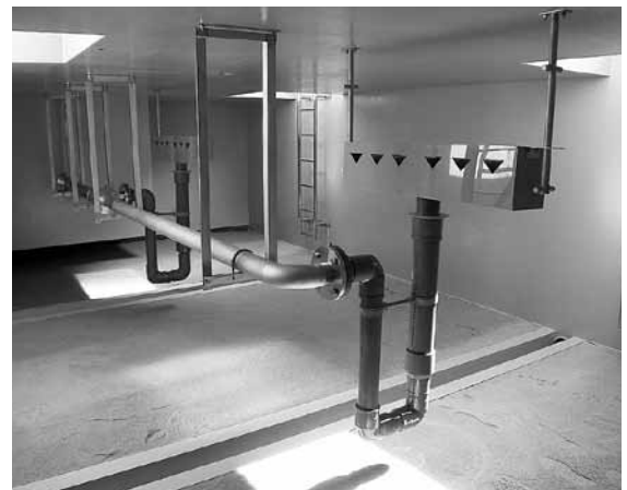
▲栃谷ろ過池内部
