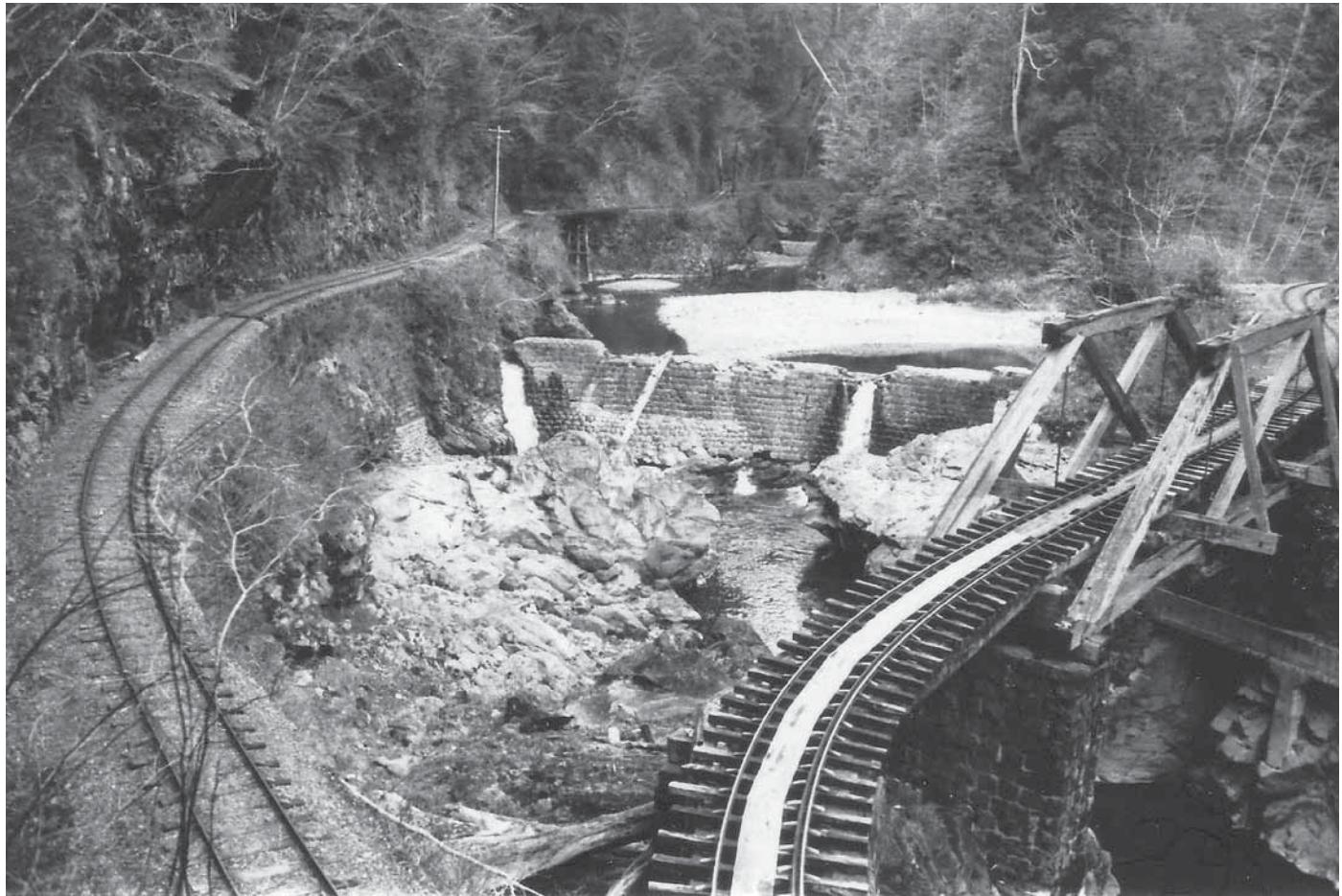
上/現在の石仙橋より少し低い位置から写したものであろう。左が西川を、右が中川を上流へ向かう軌道である。同じ場所である左ページ上の写真と比べると後年のものであることが明らかである。川をまたぐ橋には石積みの橋脚を築き、小規模ながら木造トラス橋を採用している。
