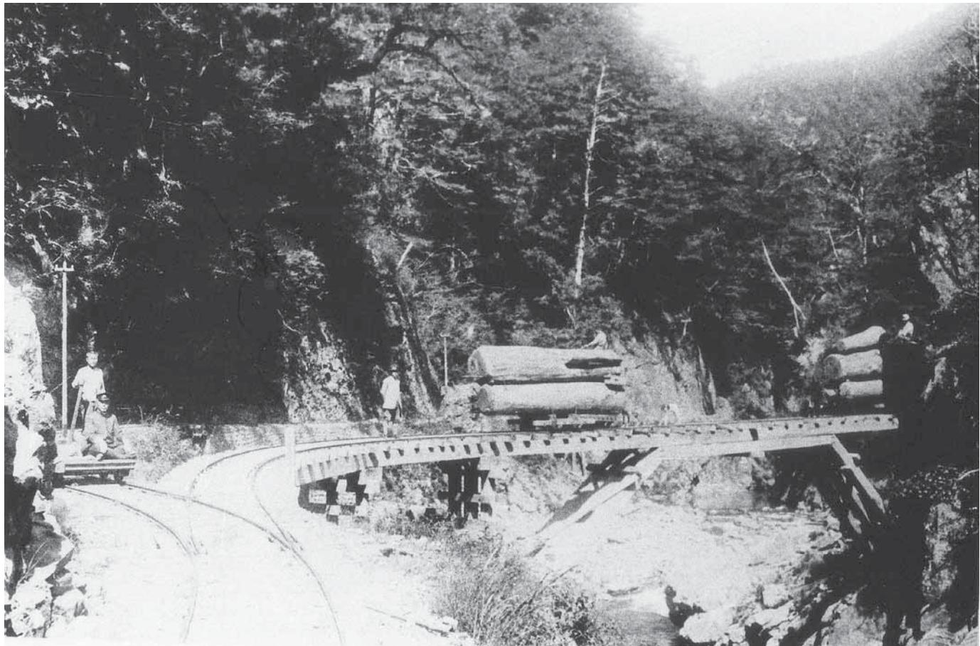
上/石仙までの本線に結んで支線も上流域に延びていった。この写真の説明にはこうある。〈寶蔵線、小屋敷線の分岐点なり、12ポンドレールを使用し、軌幅2呎6吋にして、1台の積載量15石乃至20石なり、空トロ曳上には犬を使用す〉
