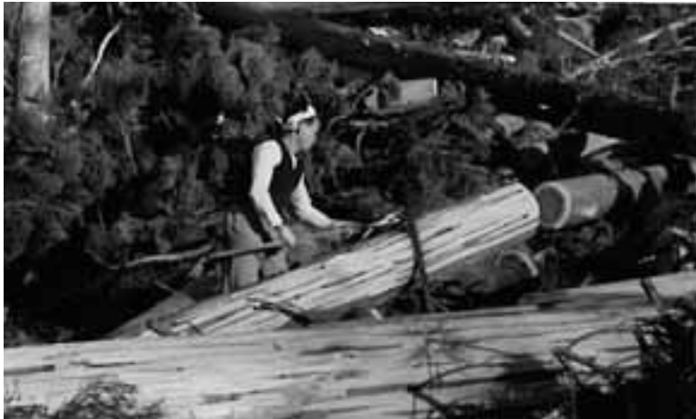
資料写真：伐倒し玉切った木材の皮を長い柄のついたカマではぐ。スギが主で樹齢は100年少々、蓄積は1800石/HA = 馬路署朝日出事業所 旧藩造林地 昭和30年頃
