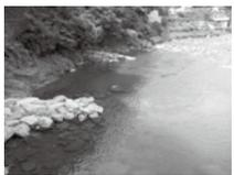
水制工を設置した後のエヤノマキ淵の様子。水制工で川の流れを変えて、淵が形成されています。（2012年7月撮影）
