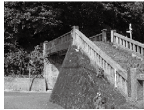
八幡跨線橋（田野町）
