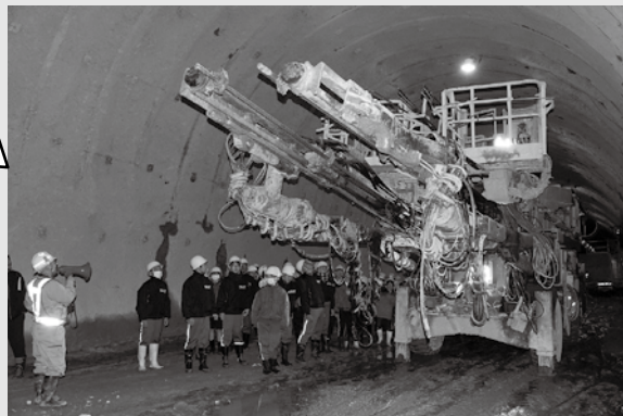
発破を仕掛け穴を作る大型機械「ジャンボ」
